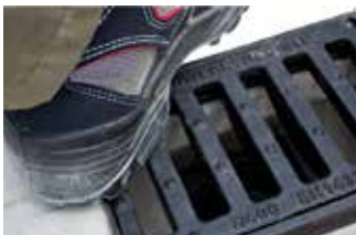
3. Rost mit einem senkrechten Fußtritt verriegeln
