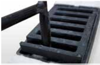
2. Aufhebeln des Rostes
